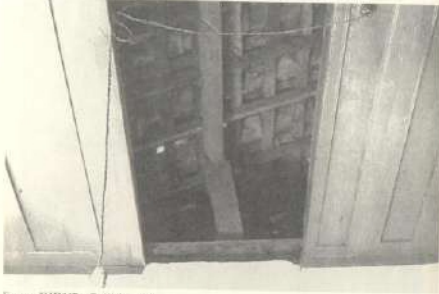
FIGURA 180: Silvânia Forro de madeira em saia-camisã associado ao forro de tecido
