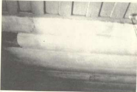
FIGURA 180: Silvânia Forro de madeira em saia-camisã associado ao forro de tecido
