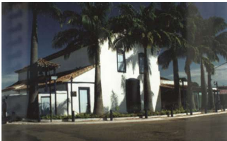
Figura 11 - fachada frontal. Fonte: arquivo pessoal Lorena S. Assunção.
