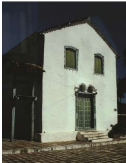
Figura 6 – fachada frontal. Fonte: arquivo pessoal Lorena S. Assunção.
