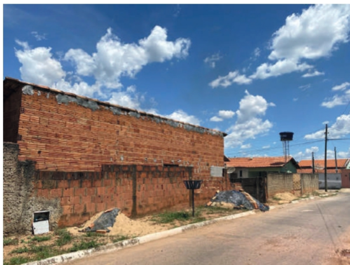
Figura 4. Barracão autoconstruído no Jardim das Vivendas, Jaraguá - GO
