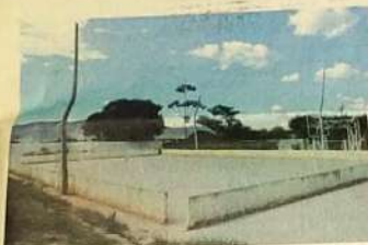
Construção da quadra na Escola Municipal Antônio Fernandes
