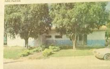
Creche Zereco, no Bairro Dona Fiça, sendo totalmente reformada
