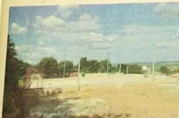
Quadra de esportes construída no Bairro Primavera, ao lado da escola Irmovides Naves
