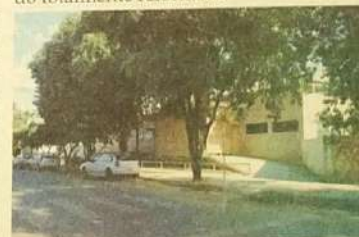
Reforma do Hospital Municipal Irmã Fanny Duran
