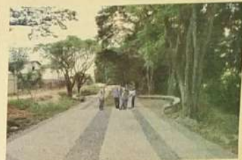
Construção do Parque das Águas
