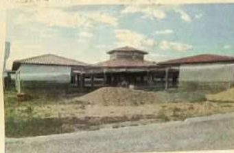
Construção da Escola no Bairro Amigo
