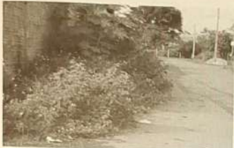
Esta é uma esquina no Setor Primavera, próxima a uma importante escola. Além dos buracos, os moradores também reclamam do mato que toma conta das calçadas e até do asfalto.
