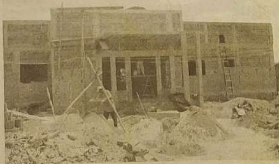
Construção do Posto de Saúde Maria Beralda
