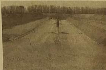
Construção da Trincheira do Aterro Sanitário
