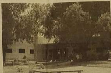
Construção do Posto de Saúde Maria Piedade
