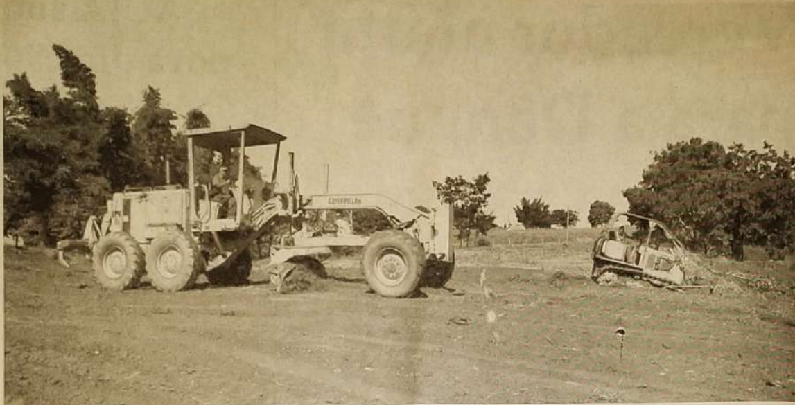
Maquinário trabalha dia e noite para entregar à população obras de infra-estrutura que vão mudar a cidade
