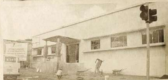
No alto, funcionários trabalham no acabamento do prédio do Centro Tecnológico da Moda, abaixo, fachada do novo Palácio da Educação. Obras serão entregues em breve
