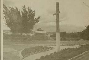
Recuperação do trevo e instalação de ponto de ônibus na Vila Isaura, saída para Itaguara
