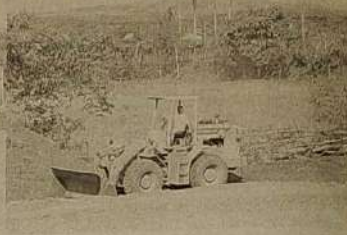
Pá mecânica que estava enchendo caminhões de terra para serem vendidos
