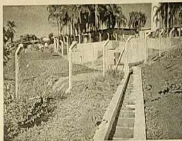
Estação de tratamento
