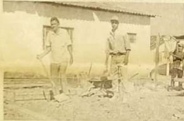
Início da construção da sede do A.A.
