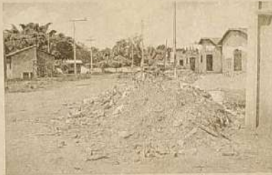
Ruas tomadas por entulhos.
