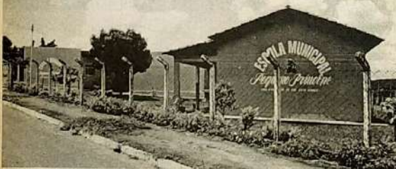
Escola Municipal Pequeno Príncipe, Totalmente reformada e ampliada.
