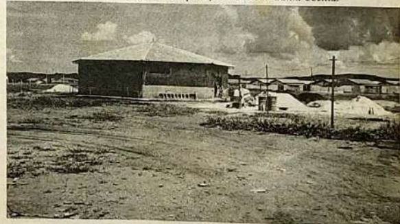
Centro Cultural em Construção (1 etapa)
