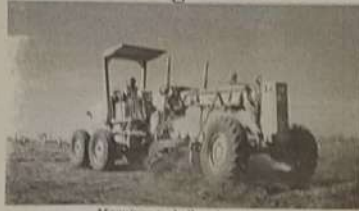
Máquinas trabalhando na obra
