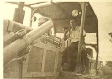
Dep. Fed. Barbosa Neto Iniciando a obra.
