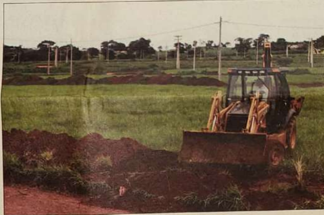
O conjunto habitacional está sendo construído no setor Dhema II
