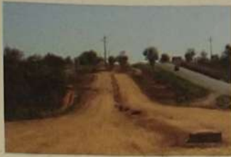
Passarela da Moda, o projeto que deverá criar às margens da BR 153 o maior espaço de comércio de confecções de Goiás
