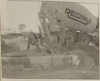
Trator e caminhão utilizados na obra da indústria de polpa.
