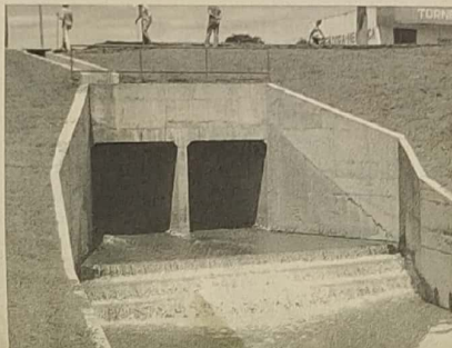
Canalização do Córrego Rio Vermelho
