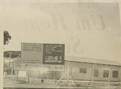
Construção da Escola do Morada Nova 2
