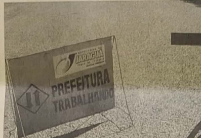
Asfaltamento do Setor Vila Verde
