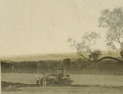
Construção da Estação de Tratamento de Esgoto
