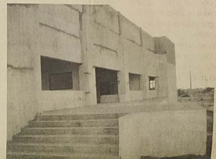
Construção do Centro Tecnológico da Moda
