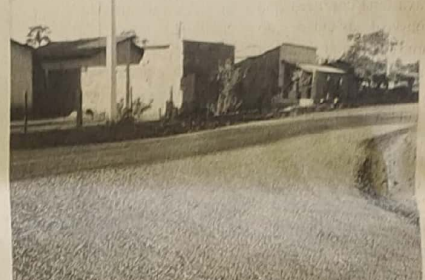
Asfaltamento do Setor Morada Nova 2
