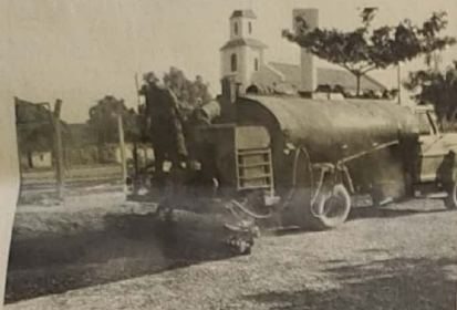
Asfaltamento do Povoado Monte Castelo
