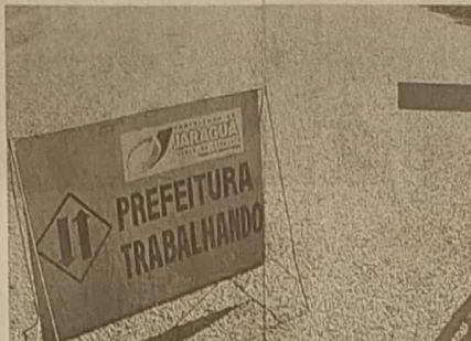
Asfaltamento do Setor Vila Verde
