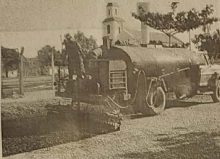
Asfaltamento do Povoado Monte Castelo
