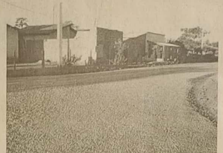
Asfaltamento do Setor Morada Nova 2
