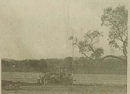
Construção da Estação de Tratamento de Esgoto
