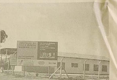
Construção da Escola do Morada Nova 2
