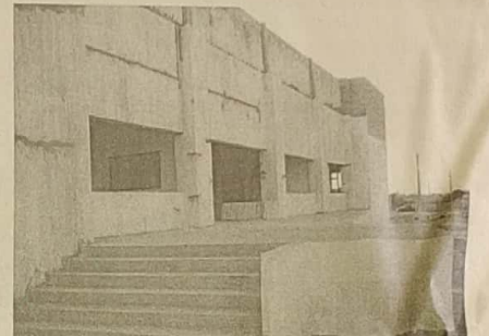
Construção do Centro Tecnológico da Moda
