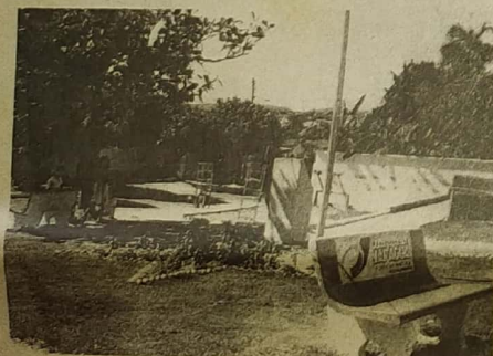
Construção e reforma de várias Praças pela cidade
