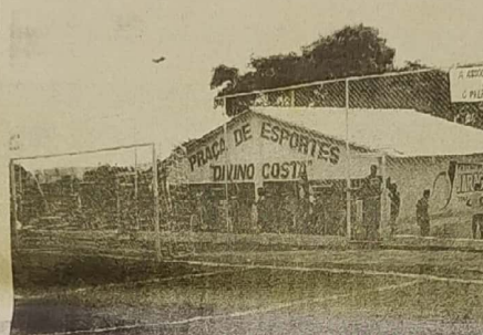
Construção de vários campos de futebol gramado
