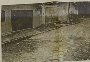
Vazamentos ficam por dias sem reparos e muitas residências com as torneiras secas
