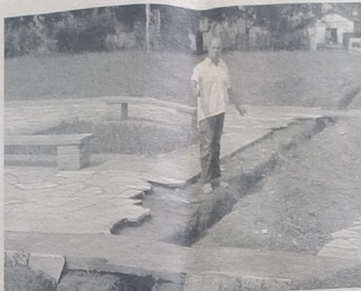
O vereador Macaúba afirma que com o período chuvoso a não conclusão da obra provocará prejuízos maiores
