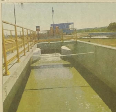
ETE de Goiânia já está tratando esgoto do Córrego Cascavel: mais saúde
