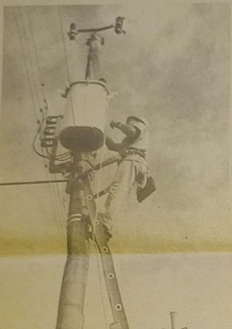
A substituição do transformador para a melhoria dos serviços prestados
