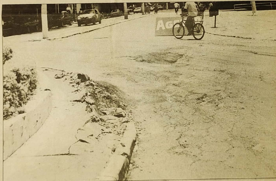
Ruas e calçadas não resistirão ao trânsito pesado provocado pelo desvio
