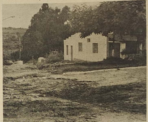
As obras de canalização da água pluvial na parte baixa da cidade deverão ser concluídas brevemente
