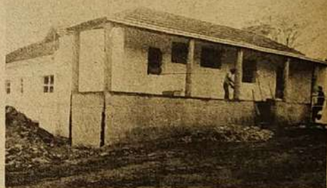
O prédio recebe reformas para abrigar a fábrica
