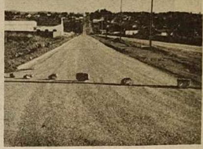
Asfalto na Av. Embaixador Fábio de Freitas
