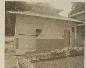
Construção de banheiros na Praça Central com modernas instalações.
