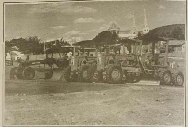
Vista dos maquinários da Regional de Jaraguá
